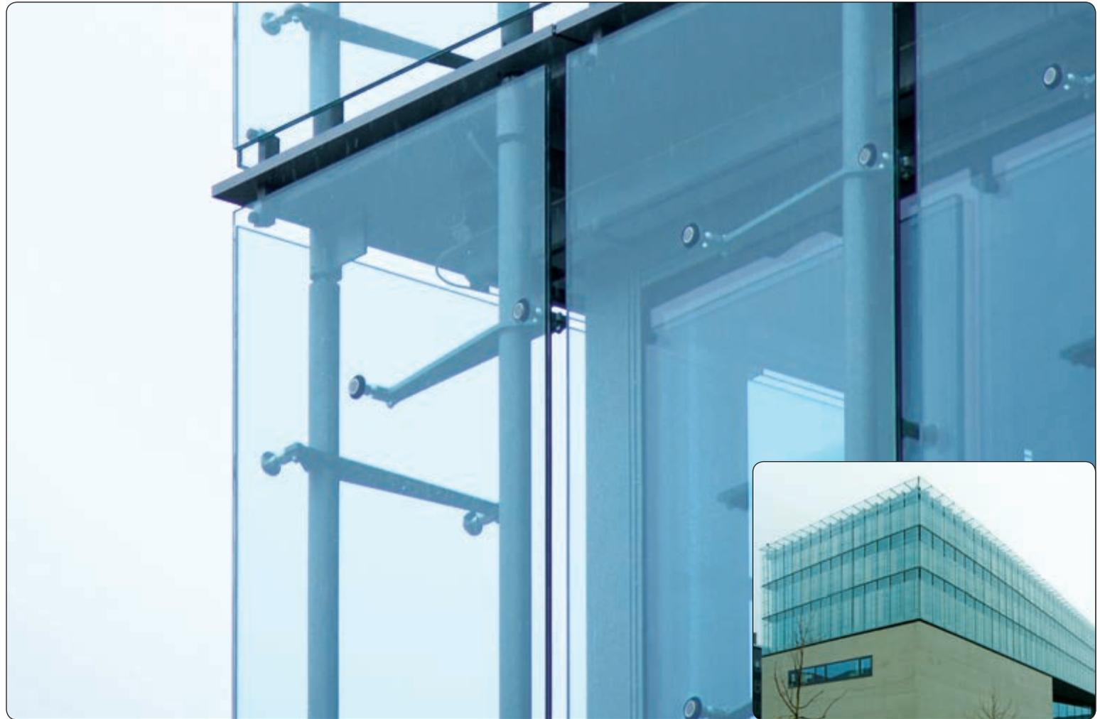
Punkthalter finden nicht nur Anwendung im Innenausbau sondern auch bei sicherheitsrelevanten Anwendungen wie Brüstungen, Überkopfverglasungen, Vordächer und Fassaden. Hier werden natürlich besonders hohe Anforderungen an Tragfähigkeit und Dauerhaftigkeit gestellt. Oft sind die Nachweise, die zu führen sind, sehr aufwendig. Außerdem ist oft eine Zustimmung im Einzelfall von der zuständigen Bauaufsicht einzuholen oder aufwendige Bauteilversuche durchzuführen.
